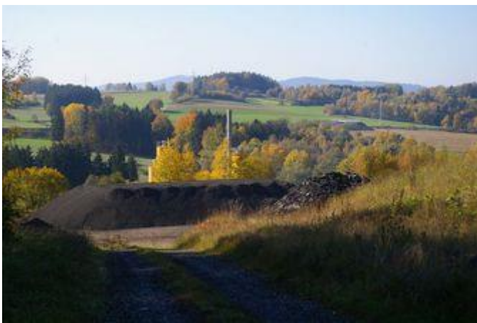
Das Asphaltwerk Hilgarth befindet sich im Nordwesten des Areals.
